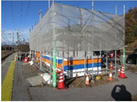
改修前の駅舎 2023 年 秋 撮影
