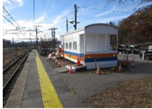
改修後の外観 2024 年春 撮影
