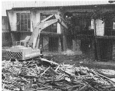
初代体育館の解体(昭和58年10月28日)
